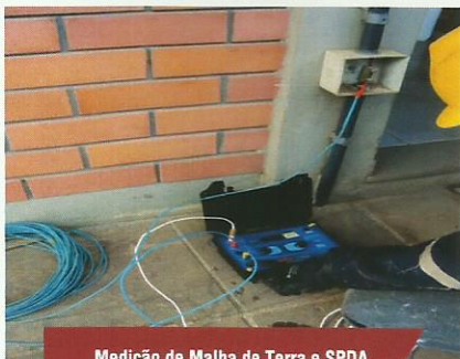
Medição de Malha de Terra e SPDA.
