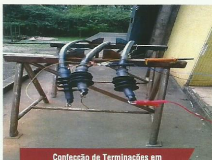
Confecção de Terminações em Cabos Isolados de MT.
